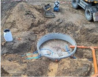
entprochen werden. Zentrale ökonomische Bedeutung des Umbaus hatten die Errichtung einer Zisterne mit 12,8 Kubikmeter Fassungsvermögen sowie eines Brunnens. Sie nutzen Regen- oder Grundwasser für die drei Entnahmestellen auf dem Friedhof und machen unabhängig vom öffentlichen Netz. Jährliche Ersparnis: ca. 1100
